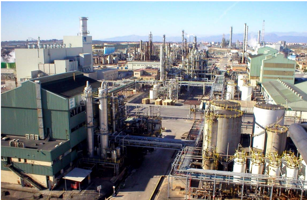
Vista general de la fábrica de Tarragona de Ercros
