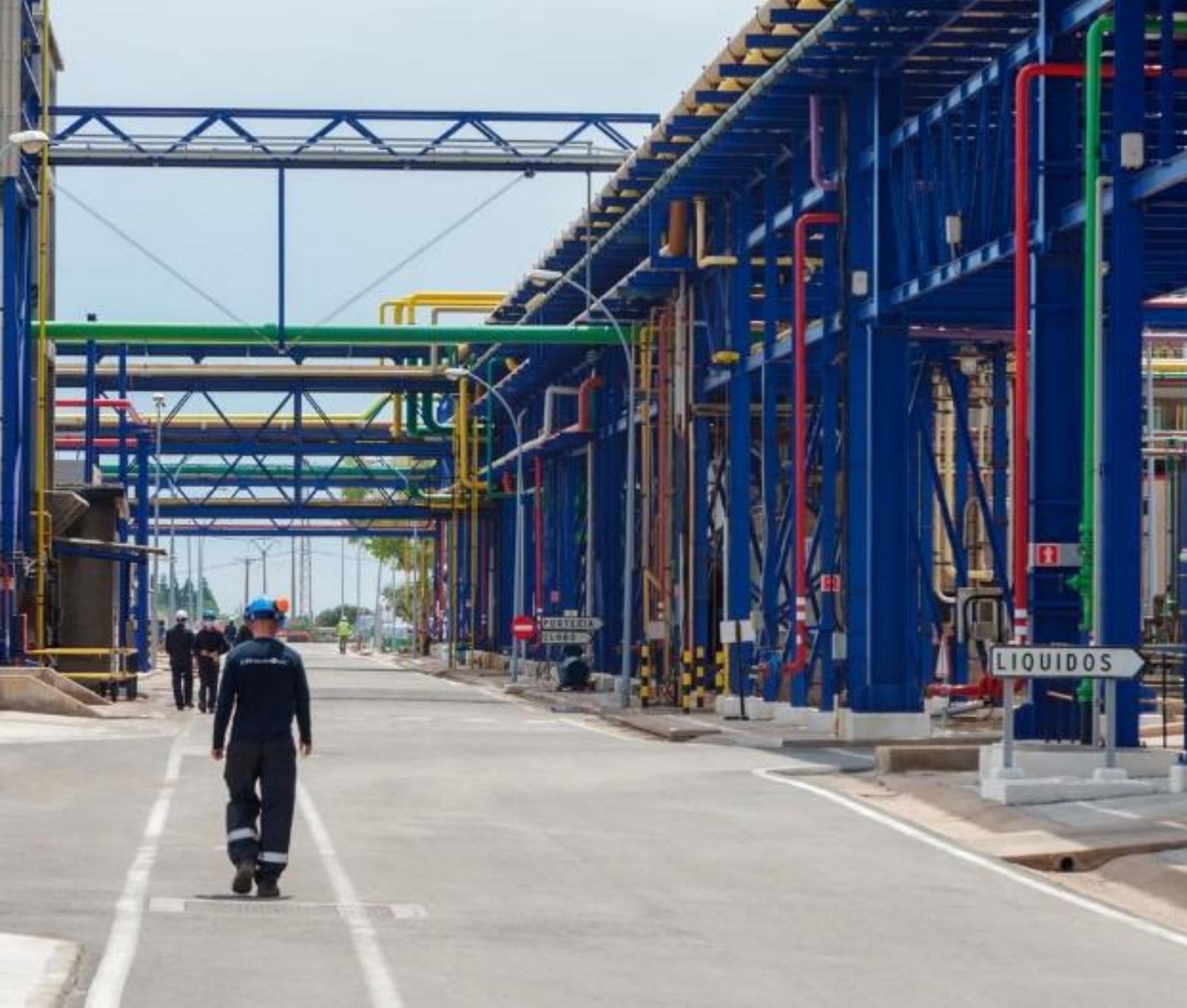
**Las tuberías del rack transportan materias primas, servicios y productos acabados a toda la fábrica**
